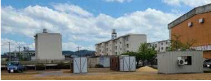
業者の現場事務所と駐車場（校庭のすみ、プール西隣）
