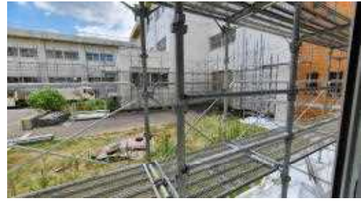
校舎・体育館の全周囲に足場を設置
