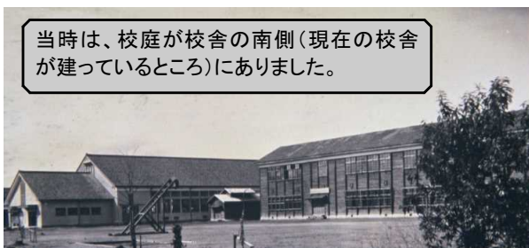
S24.3.10 新校舎(南校舎)建設
