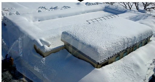
2/7 プール管理棟
